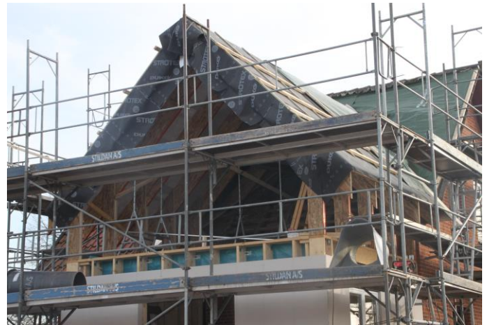
Stillads, men ingen kran.
