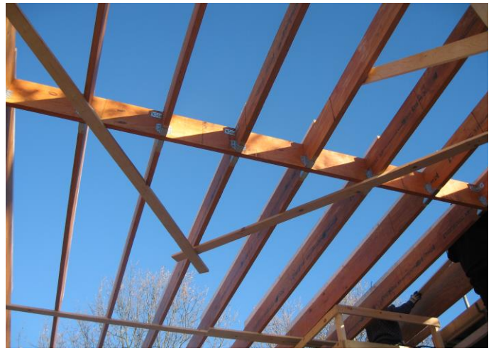
Tagkonstruktionen afstives midlertidig med diagonale forskallingsbrædder.
